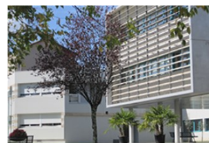
EHPAD CHICRDD SITE CHENARD Rue du Dr Broquaire 24410 ST-AULAYE-PUYMANGOU 05 53 92 43 00
